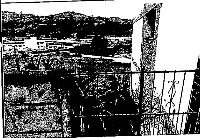
Rua Ribeiro Junqueira - Lateral esquerda
